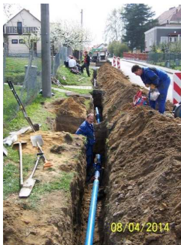
Oprava VDV řadu DN100 na ulici Rovniny
