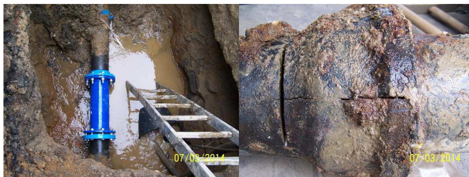
Porucha na VDV řadu DN150 ulice Zahradní
