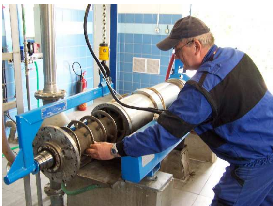
Servis odstředivky Andritz
