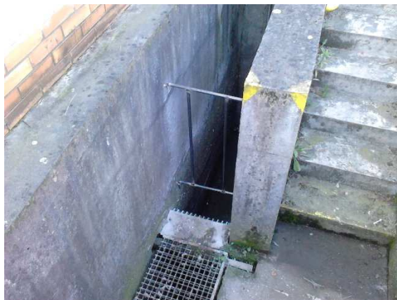
Úprava pracoviště - zábradlí
