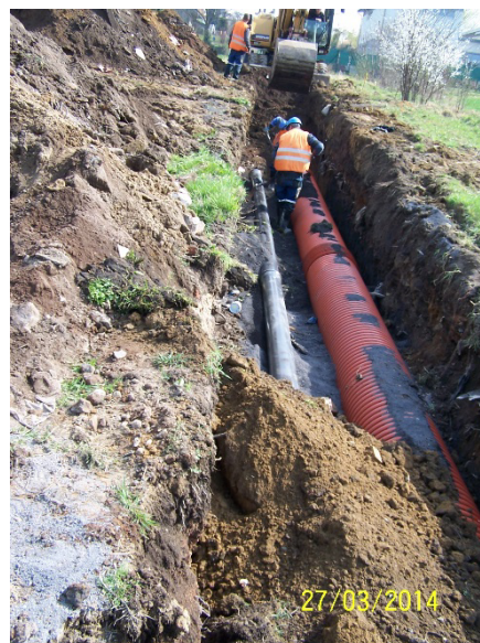
Oprava odlehčovací stoky DN600 ulice Moravská
