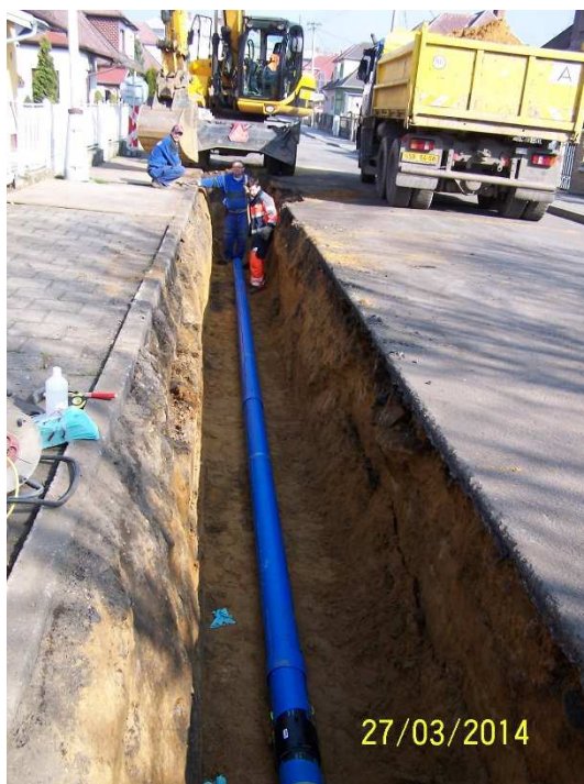
Oprava VDV řadu na ulici Pekařská
